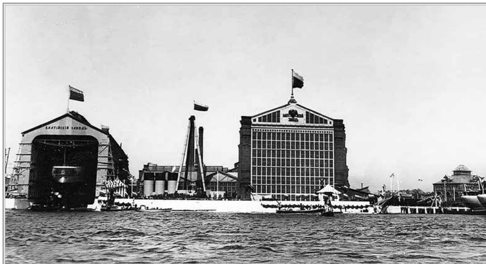
Стапель Балтийского завода, вид с Большой Невы
