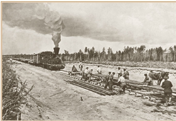
Строительство Транссибирской магистрали
