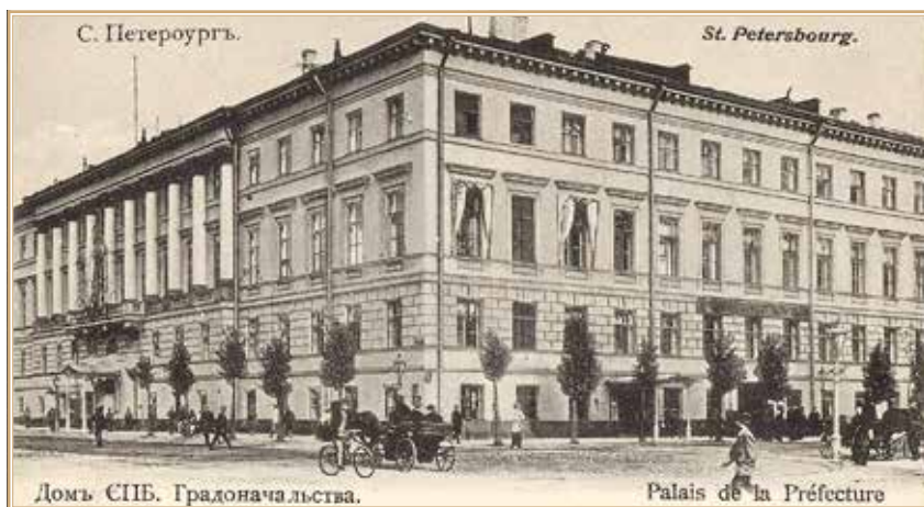
Здание Санкт-Петербургского градоначальства. Помещение охранного отделения. Открытка 1896 г. Из открытых источников
